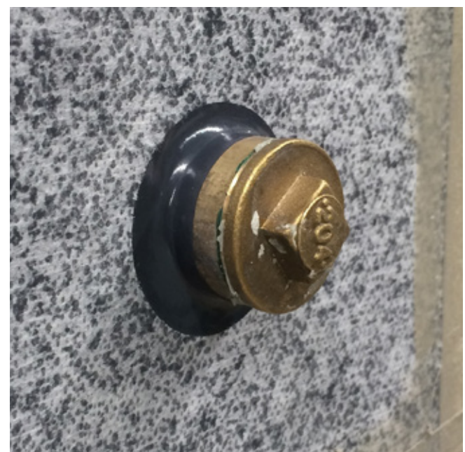
Praxisbeispiel: Rohrdurchführung mit Dichtmanschette
