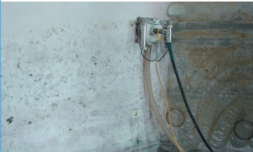
Bild 6: Besser ist es, den Schimmelpilz durch ein Sprühextraktionsverfahren zu entfernen. Dadurch verringert sich die Sporenexposition und die Tätigkeit kann in eine geringere Gefährdungsklasse entsprechend Abschnitt 5.2.1 eingestuft werden (mittlere Sporenbelastung → Gefährdungsklasse 2)
