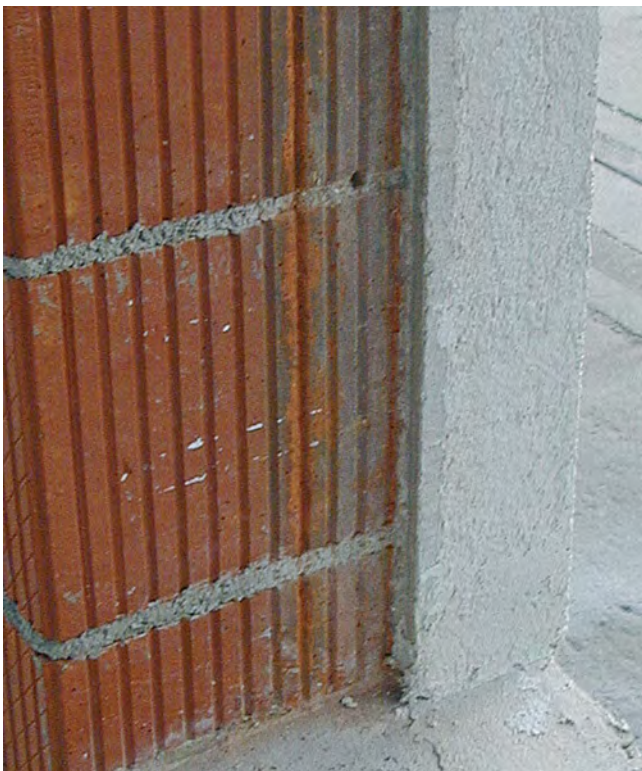
Abb.1 Rohbausituation vor dem Glattstrich
