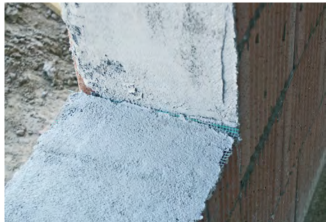
Abb. 2 Rohbausituation mit Glattstrich
