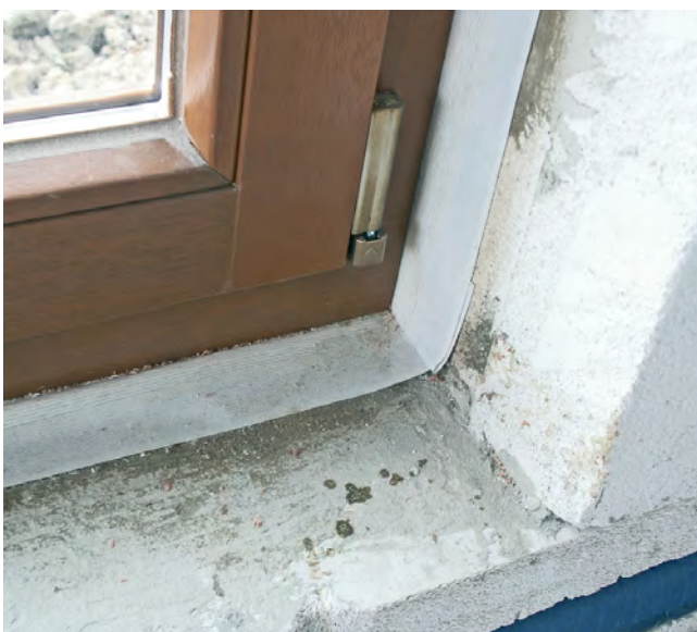
Abb. 5 Eckausbildung mit Fensteranschlussfolie, innen
