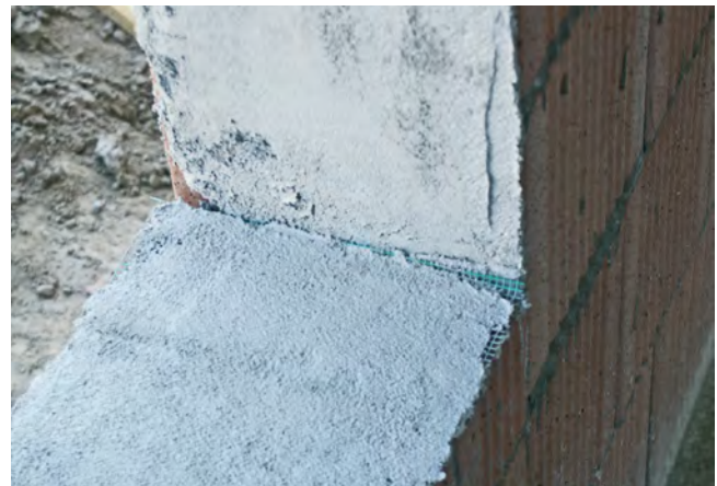
Abb. 2 Rohbausituation mit Glattstrich
