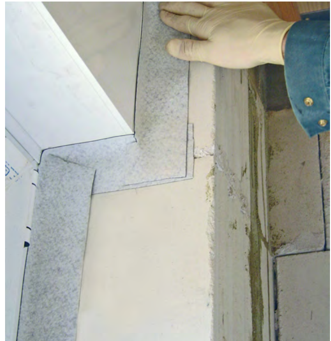
Abb. 6 Eckausbildung mit Fensteranschlussfolie am Rollladenkasten
