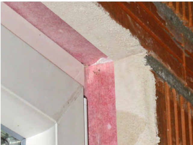
Abb. 9 Eckausbildung mit Fensteranschlussfolie und Klebepaste auf Glattnstrich
