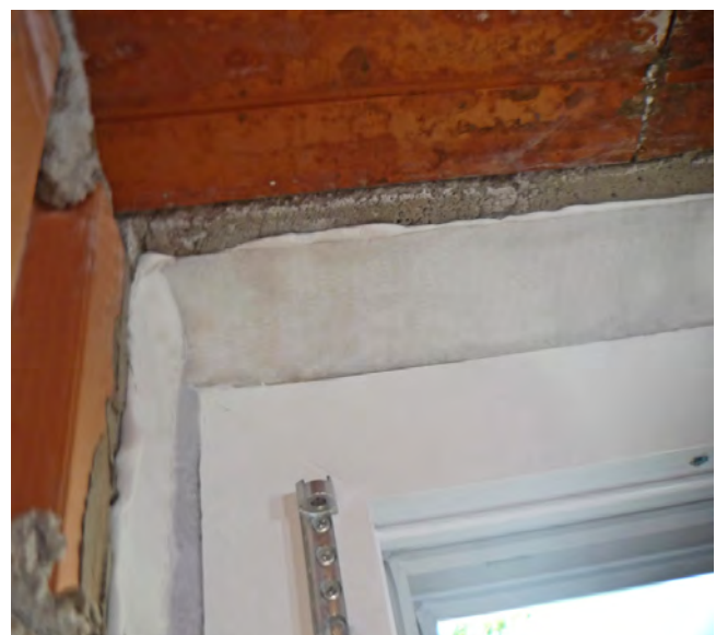
Abb. 7 Eckausbildung mit Fensteranschlussfolie und Klebepaste in der Altbaumodernisierung
