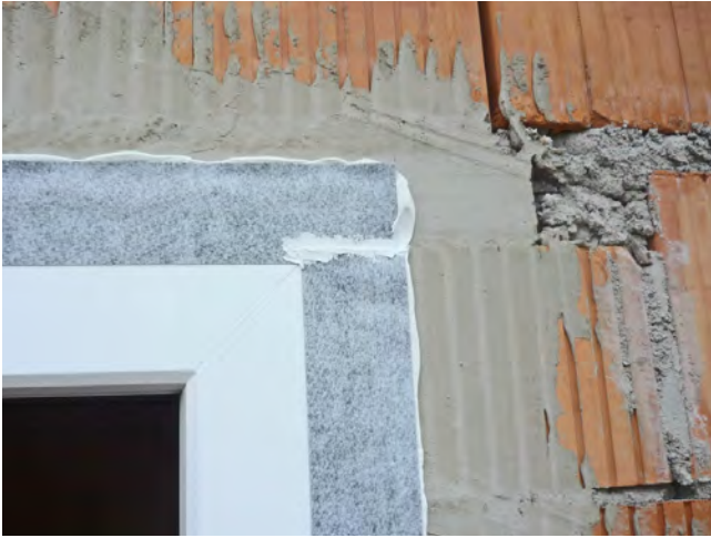
Abb. 8 Eckausbildung mit Fensterschlussfolie und Klebepaste im Außenbereich vor Anbringen eines Wärmedämm-Verbundsystems
