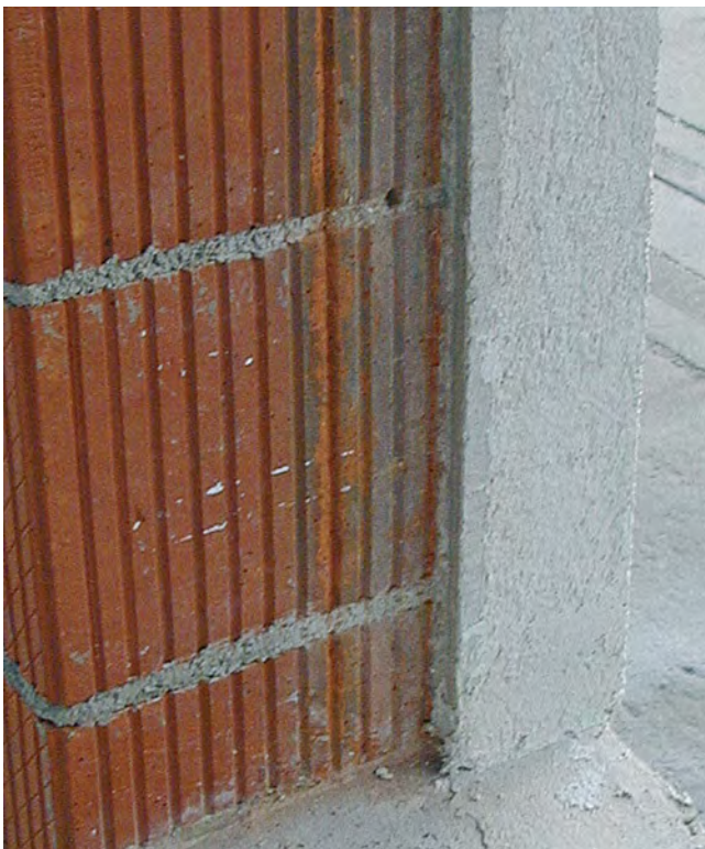
Abb.1 Rohbausituation vor dem Glattstrich
